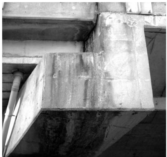
写真 コンクリート表面の黒い汚れ
