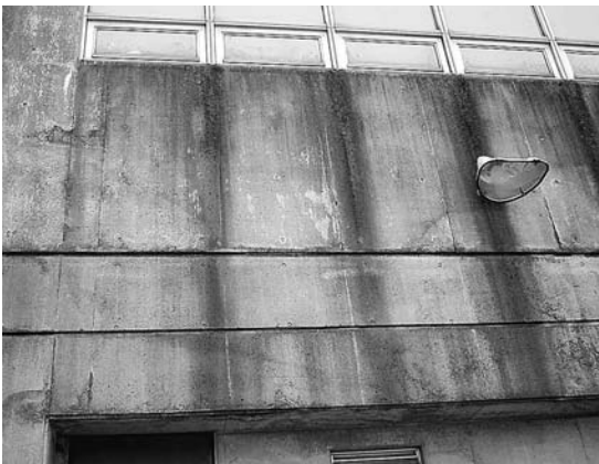
写真 コンクリート表面の黒い汚れ
