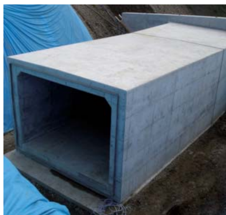
写真 3-1 ボックスカルバートの壁
