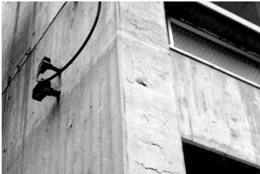
写真3 中性化による鉄筋腐食でひび割れ・はく離が発生(約5年経過建物のかぶり不足の柱)
