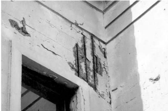
写真1 中性化による鉄筋腐食でかぶりコンクリートがはく落(約50年経過建物の壁)
