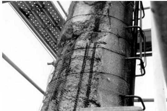
写真4 煙突のコンクリートが中性化し鉄筋が腐食して変化した例
