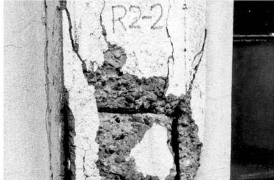
写真2 中性化による鉄筋腐食でかぶりコンクリートがはく落(約50年経過建物の柱)
