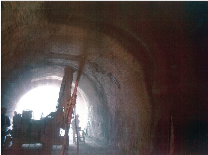
急結剤を用いたトンネル用吹付けコンクリート
