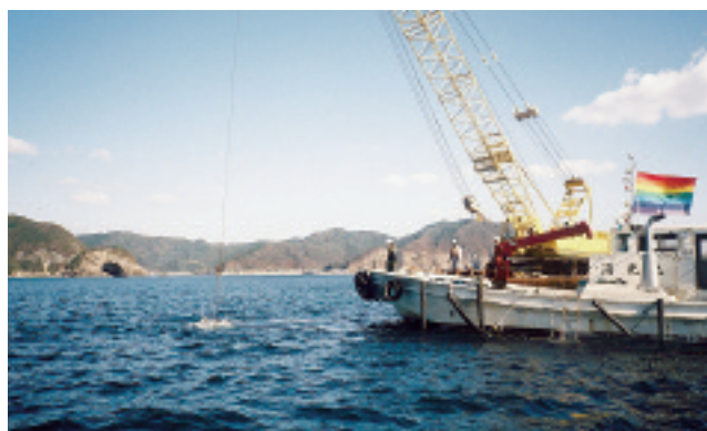
写真6 ブロックの沈設作業
