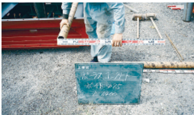
写真2 ブロック内挿入管(φ75mm)
