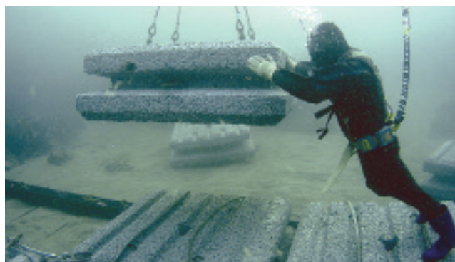
写真7 ブロックの沈設作業
