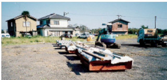
写真4 打設後養生
