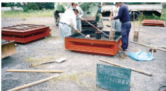
写真3 コンクリート打設状況
