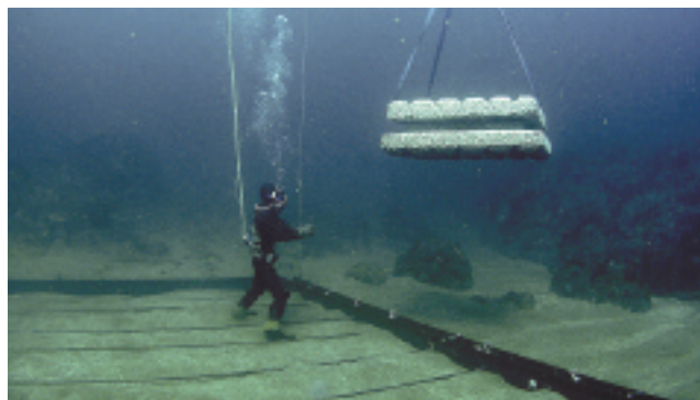
写真6 ブロックの沈設作業
