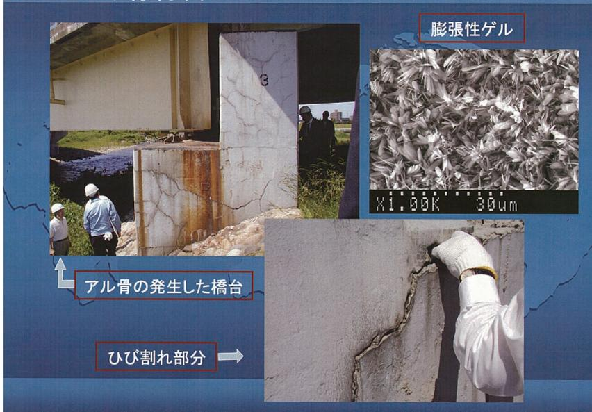
化学混和剤によるアルカリ骨材反応の抑制対策は、1951年 McCoy らにより、リチウム系混和剤が有効であることが発表されています。その後、日本でも  $\text{LiNO}_2$  水溶液をセメントに添加することにより、Li イオンが  $\text{SiO}_2$  と Na との反応に関与し、 $\text{Na}_2\text{O} \cdot n\text{SiO}_2$  の生成を阻害していることが報告されました<sup>3)</sup>。水酸化リチウムの影響について研究した報告では、リチウム化合物を添加すると速やかに  $\text{Li}_2\text{O-SiO}_2$  ゲルが生成し、この  $\text{Li}_2\text{O-SiO}_2$  ゲルはあまり吸水膨潤性を持たないことが示されています<sup>4)</sup>。
